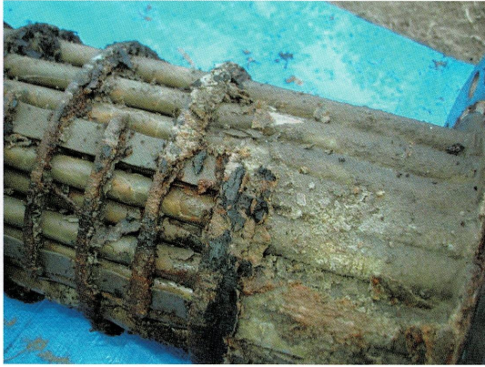
取付前の清掃時
